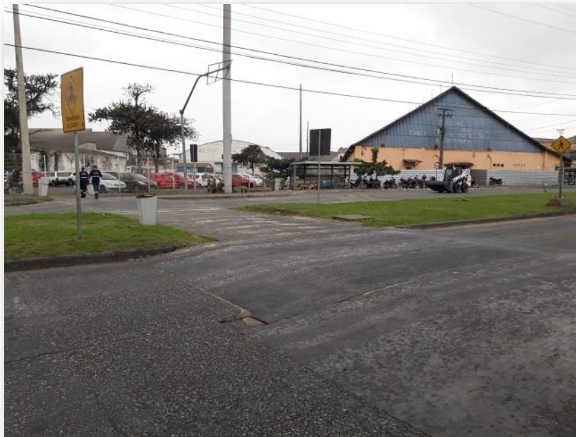
Figura 62. Faixa elevada para travessia de pedestres. Av. Portuária, bairro Dom Pedro II
