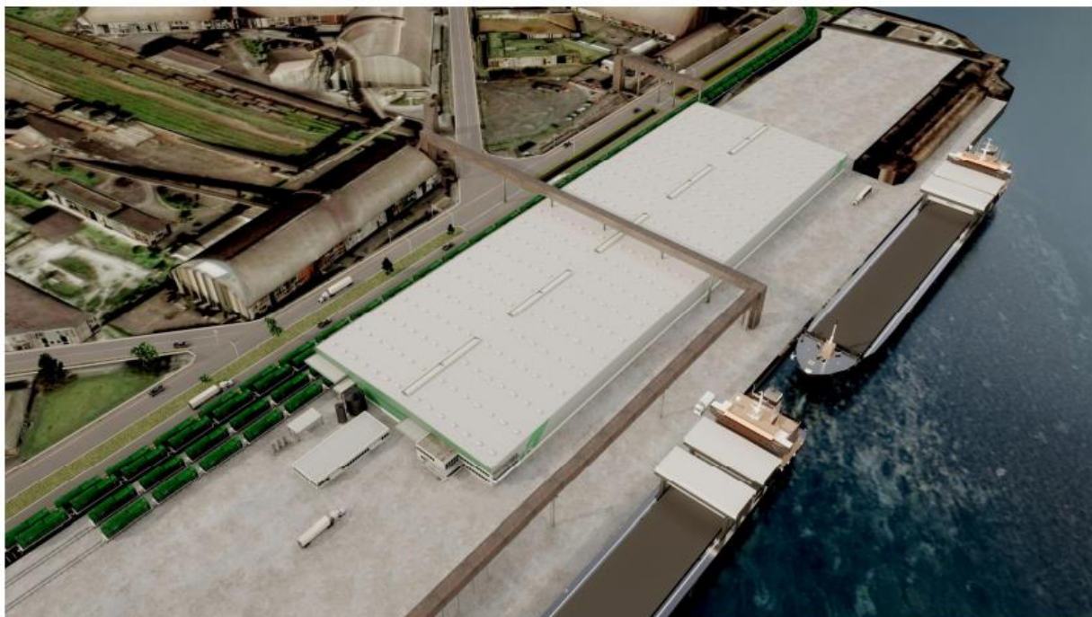
Figura 08. Perspectiva do empreendimento visão lado marítimo – Klabin S/A Fonte. Pöyry Tecnologia Ltda
